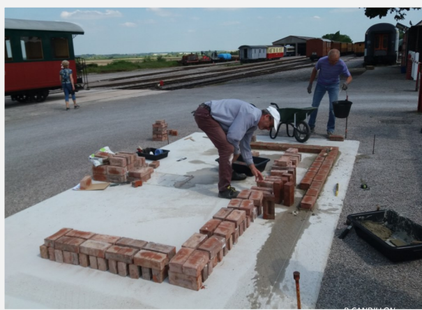
Pose de la base de l'abri de Saint Valery Canal lors d'un « Thursday gang ».
