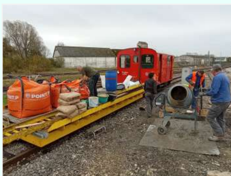
11/2025 : préparation du béton de la base du carré C16 de Noyelles
