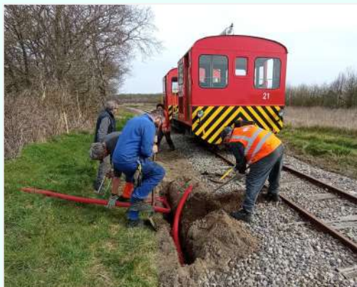
20 mars, on creuse les tranchées pour passer les fourreaux des câbles du PN « de chez Vaillant ».
